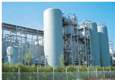
神戸工場にあるバイオマス熱利用施設
