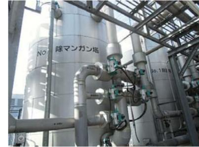
除鉄塔・除マンガン塔、活性炭塔。用水中の鉄などの不純物を取り除き、生産に適した水にする
