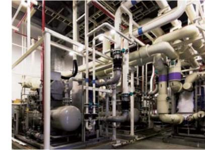
スクリーン冷凍機。水などを冷却する装置。ここからパイプで各工程に送り、原料や製品を冷却する
