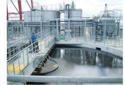
排水処理施設。微生物が排水の有機物を分解する「活性汚泥処理法」により、排水を浄化する
