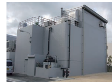
上・沖繩森永乳業に新設された排水処理設備。右・活性汚泥中の微生物。有機物質を栄養分として吸収し、排水中の有機物を減らしてくれます。
