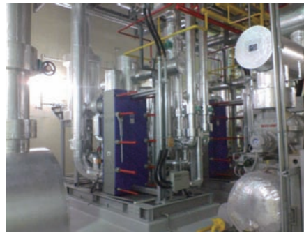
過冷却設備外観。手前が過冷却水をつくるプレート。
