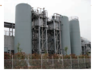
バイオマス熱利用設備のメタン発酵プラント。
