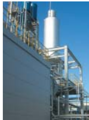
利根工場コージェネレーションシステム 6,000kW×2基。工場で余った電力は外部に売却しています。
