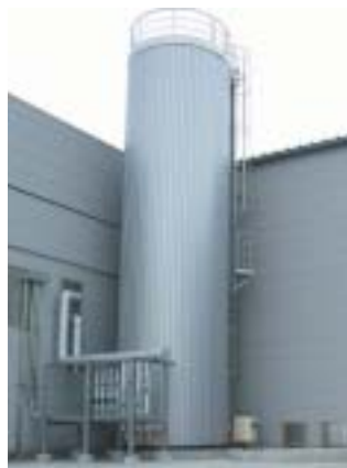
アイスバンクには、水槽が箱型のもやサイロ型ものなどがありますが、このスパイラル状のコイルが数十段積み重ねられたアイスバンクサイロは、箱型のものに比べ、さらに省エネルギーで省スペースという利点があります。
