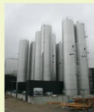
建設中のミライ社新工場
