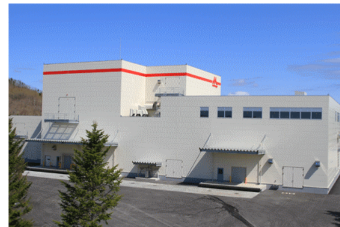
浦幌乳業新製造棟
