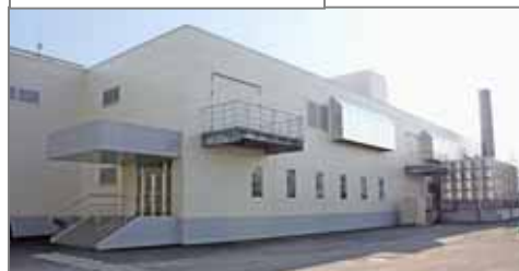
別海工場新チーズ製造棟
