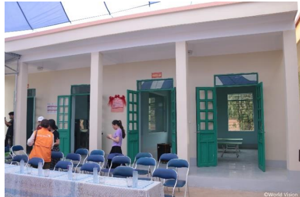
引き渡しを行った調理施設の外観
